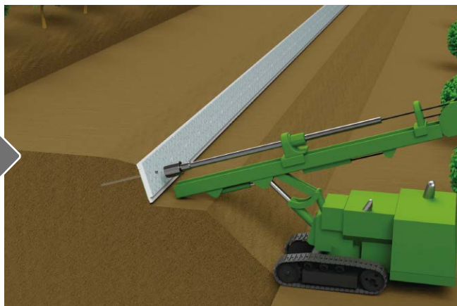
STEP 5 削孔・定着材注入・芯材組立て・挿入
