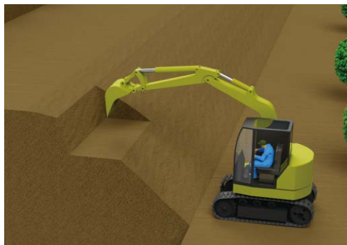
STEP 1 掘削・法面整形
