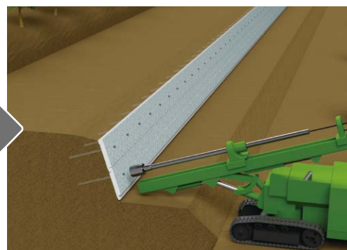
STEP 10 削孔・定着材注入・芯材組立て・挿入
