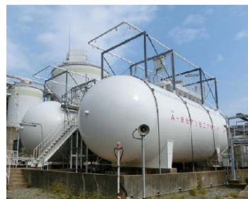
危険物貯蔵タンクの補強事例
