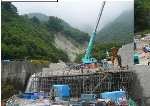
仮設足場状況
