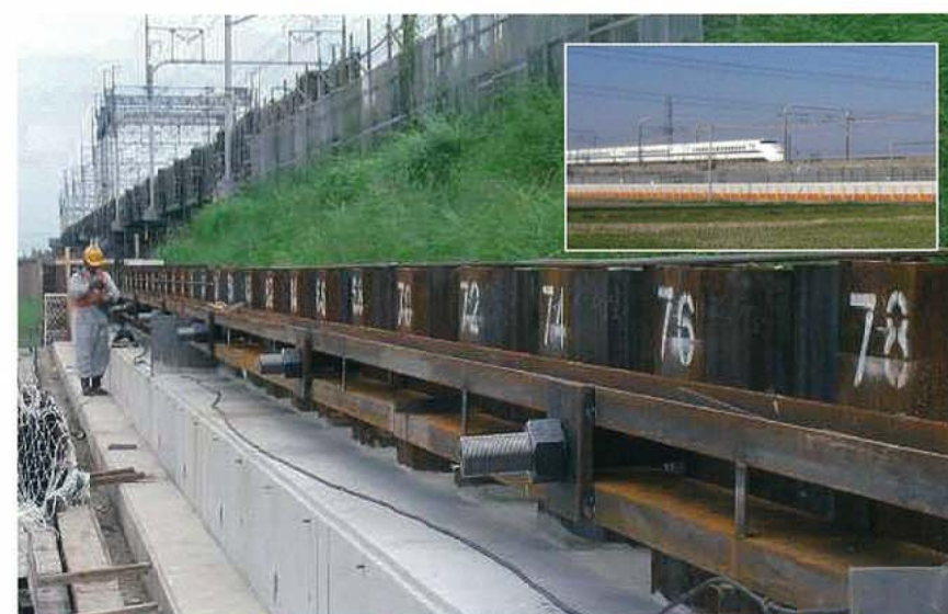
新幹線耐震盛土
