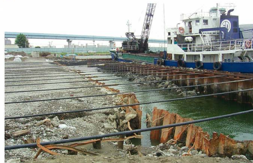
港湾控索施工
