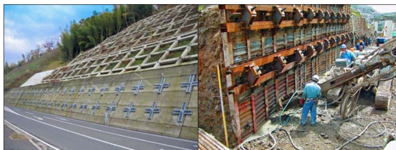
タイブルアンカーU型 KIT受圧板
