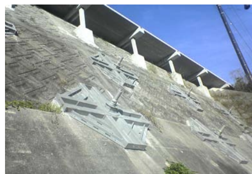
＜コンクリート壁補強＞
