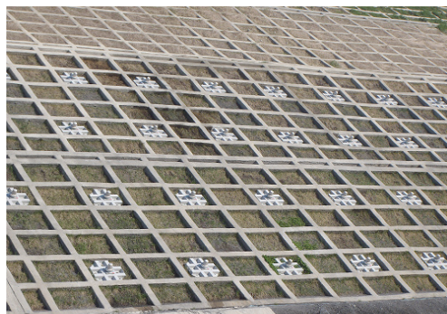
＜法枠内設置例＞
