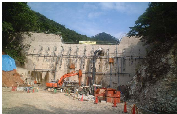
グラウンドアンカー工法による砂防えん堤の補強事例
