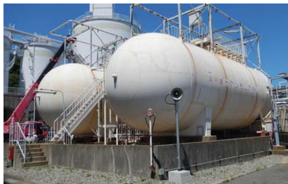
【液化アンモニア貯蔵タンク（津波対策工前）】
