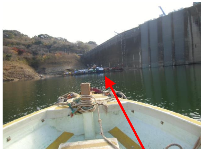
ダム堤体上流側施工箇所
