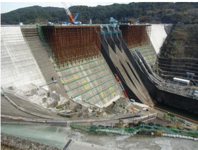
ダム堤体下流側側面
