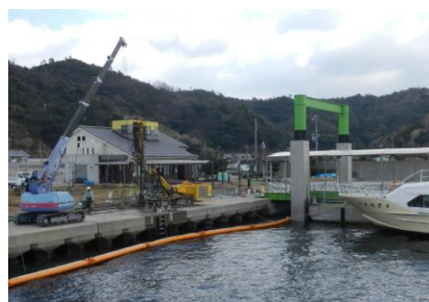
ブロック式岸壁の補強例
