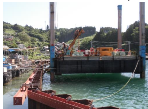
矢板式岸壁の補強例
