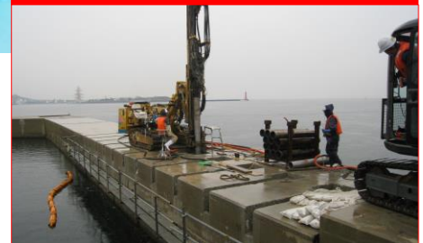
【岸壁・護岸補強アンカー】
