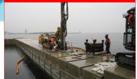
【岸壁・護岸補強アンカー】
