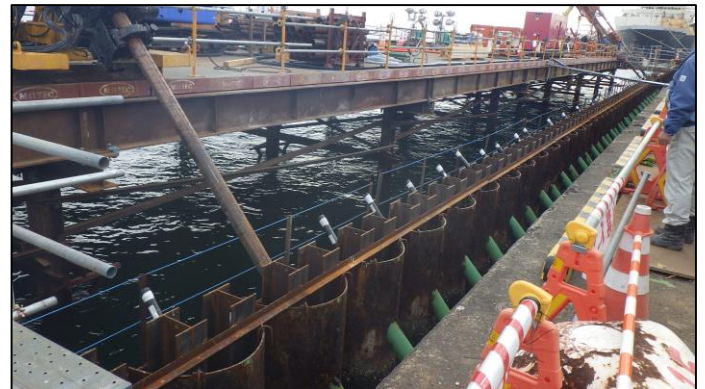
削孔作業状況
