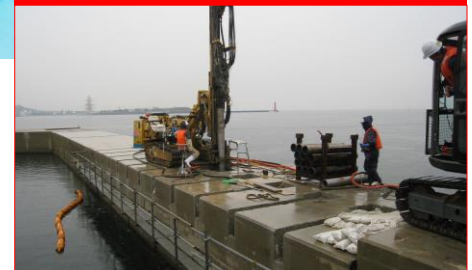
【岸壁・護岸補強アンカー】
