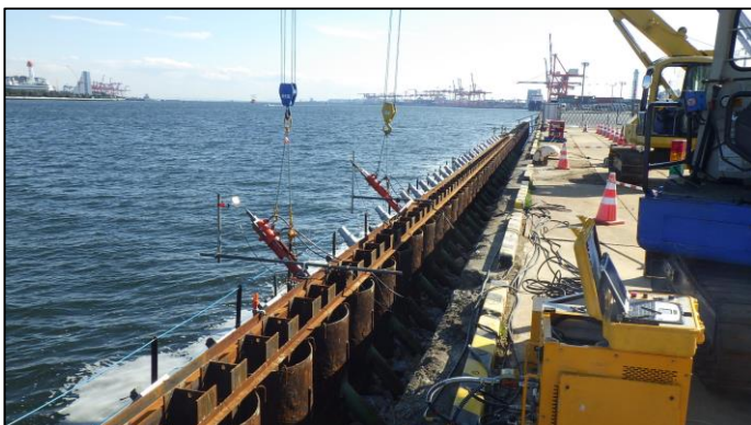
緊張作業状況
