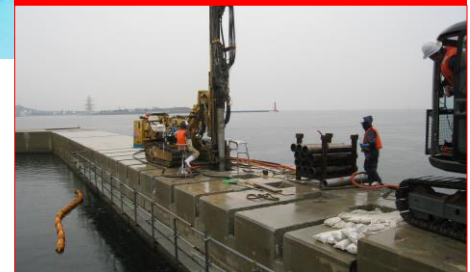
【岸壁・護岸補強アンカー】
