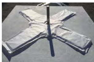
ざぶとん材敷設状況
