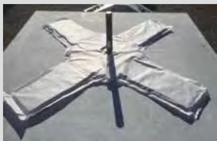
ざぶとん材敷設状況
