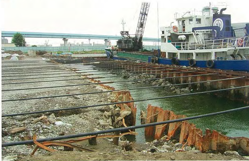
港湾控索施工
