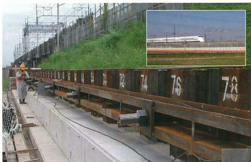
新幹線耐震盛土
