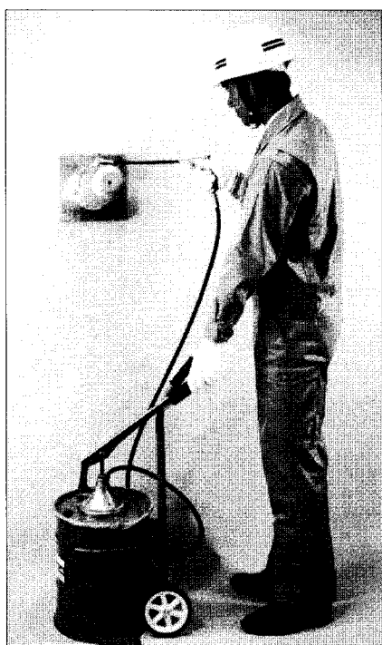
解説写真 5-11 防錆材充填
