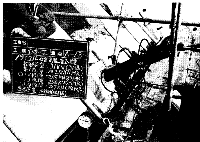
解説写真 5-18 緊張状況
