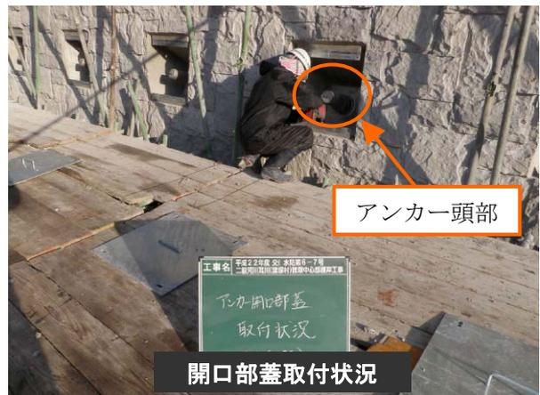
■河川護岸の場合、降雨による水位の上昇で流木等がアンカー頭部に接触し、保護キャップが破損するなどの機能の低下が懸念されます。本工事では張りコンクリートに開口部を設け鋼製の蓋を設置することで、**アンカー頭部が露出しない構造**としています。
