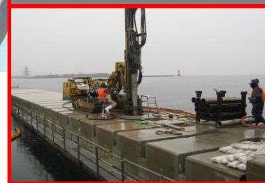
【岸壁・護岸補強アンカー】
