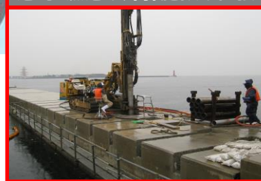
【岸壁・護岸補強アンカー】
